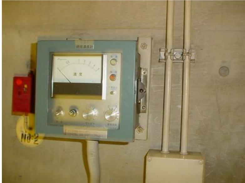
S 2 1 形を壁掛タイプで御使用の場合、交換機種はS 3 0 0 0 形、S 4 0 0 0 形になります。投光器・受光器につきましては、共通ですので指示変換器の仕様で交換機種が選定されます。主な仕様の違いは下記の通りです。(基本性能は同じです。)
